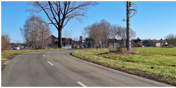
A 6534. j. ök. út íves szakasza Dombóvár felől
