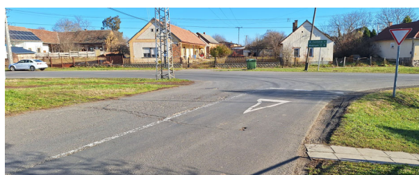
Az alárendelt 6539. j.ök. út csatlakozása
