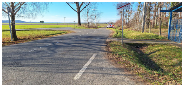
Az alárendelt 6539. j. ök. út csatlakozása
